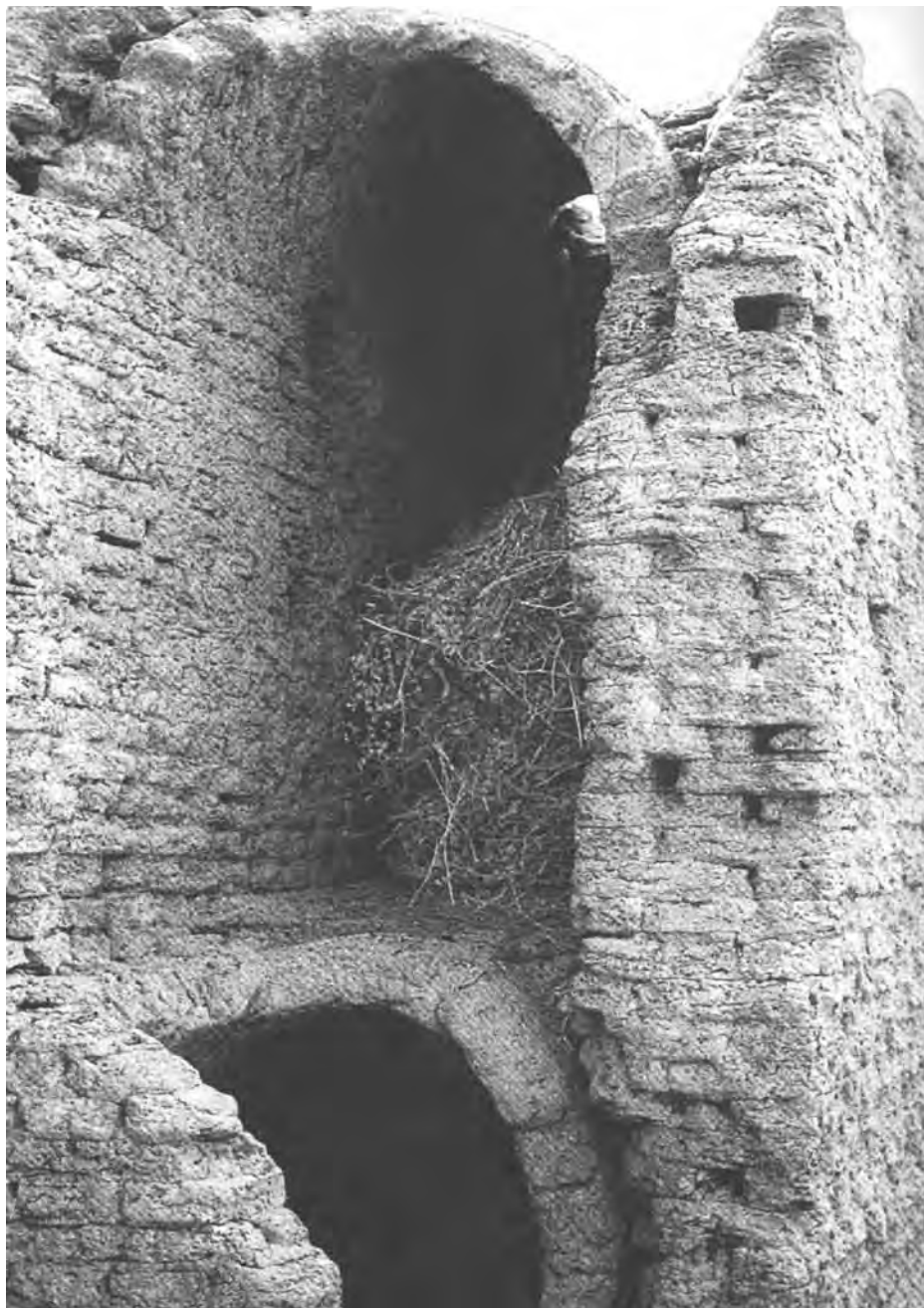
FIGURA 28.2 Casa de tijolo cru: cômodo abobadado (Fonte: © CNRS. La prospection archéologique de la vallée du Nil au sud de la Cataracte de Dal , fascículo 2, publicado pelo Centre national de la recherche scientifique, Paris, 1975).
